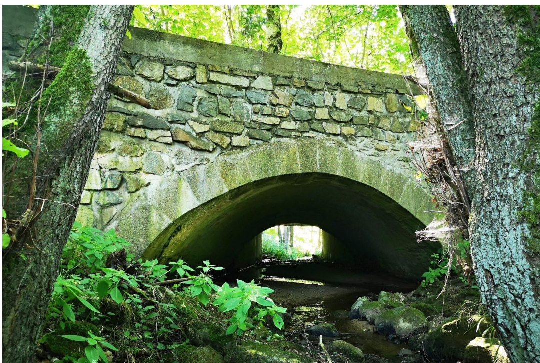
Klenutý most ve Strži, u kterého není známo kdy byl postaven, sloužil staré silnici E 15 do roku 1976. Ve směru tekoucího potoka byl dlouhý deset metrů. V roce 1976 byl ve směru k jihu prodloužen, v hranatém profilu, o patnáct metrů. Nad prodlouženým mostem byla vybudovaná nová silnice o tři metry výše proti původní silnici. Podle mapy „Stabilního katastru“ zde stál v roce 1835 ještě jen most dřevěný. Je otázkou, ve které roce byl tento klenutý most postaven.
