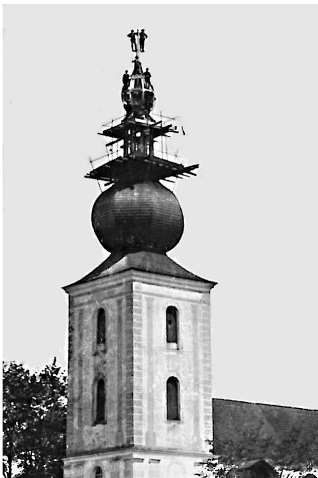
Výměna dřevěného kříže a pokrývání malé bání a lucerny měděným plechem. Foceno 8. května 1905
