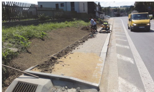
Výstavba chodníku na ul.Černická
