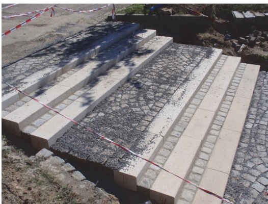
Schodiště u semaforu
