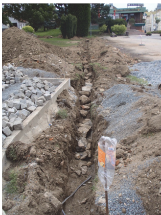
Výstavba nového oplocení ZŠ a chodníku
