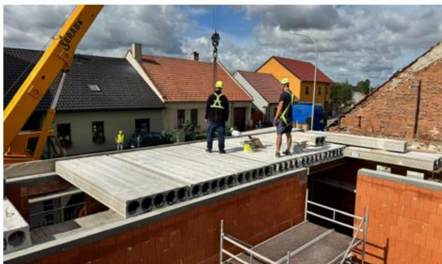
Pokládání stropních panelů
