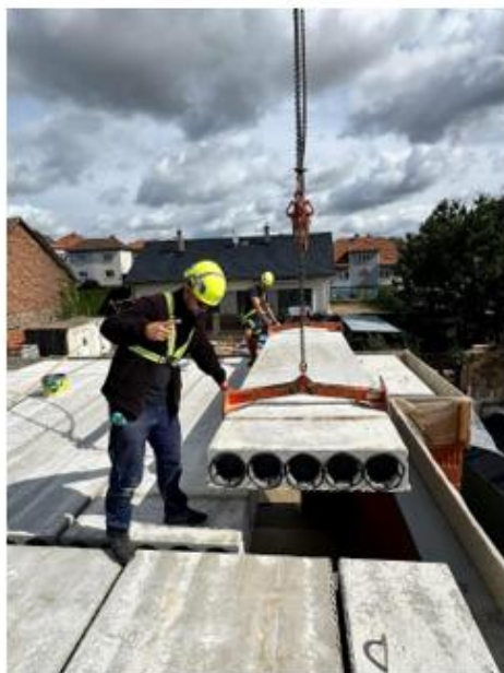
Pokládání stropních panelů
