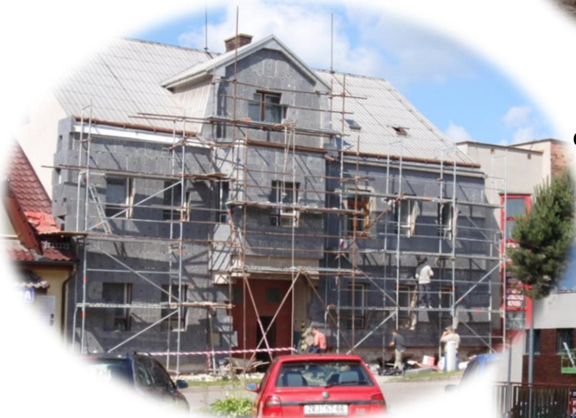
Oprava budovy firmy DAKIN s.r.o. (Kras)
