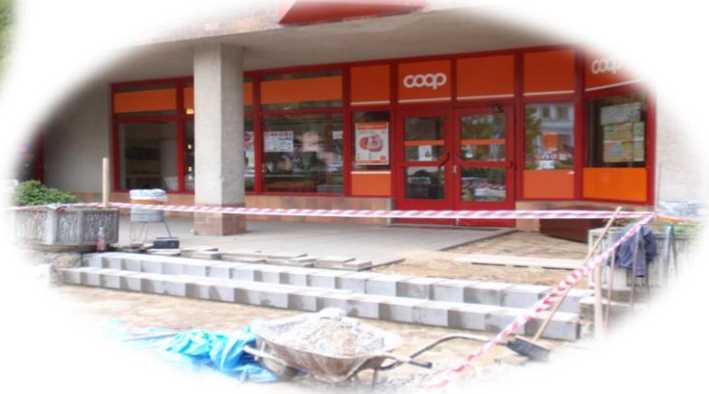
Oprava vchodu a chodníku - COOP
