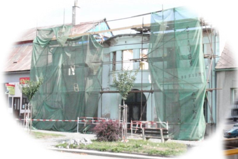
Demolice domu č.p.101 na Náměstí
