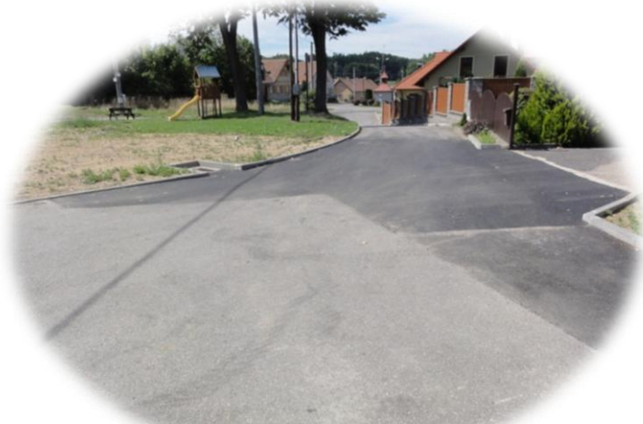
HOTOVO –září 2015 Kanalizace Pustina IV.etapa
