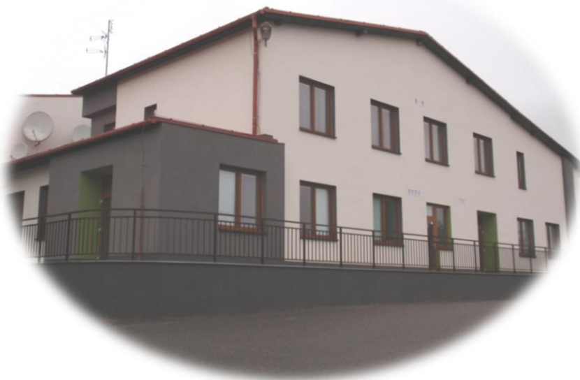
HOTOVO - říjen 2015 – Zateplení budovy Zdravotního střediska Měřín
