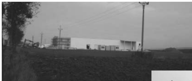
Za Měřínem směrem na Černou vyrůstá skladová hala Agra-Měřín a.s.
